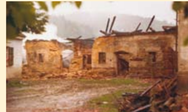
Das Stallgebäude von Familie Terler brannte bis auf die Grundmauern nieder.
