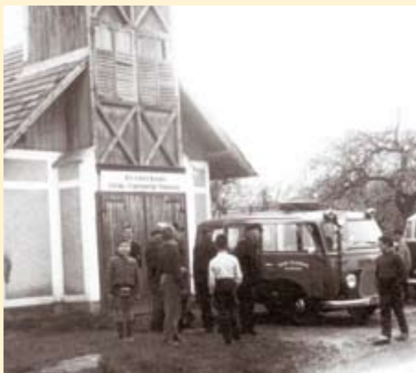
Das Gerätehaus mit dem hölzernen Steigerturm vor dem Umbau 1965.
